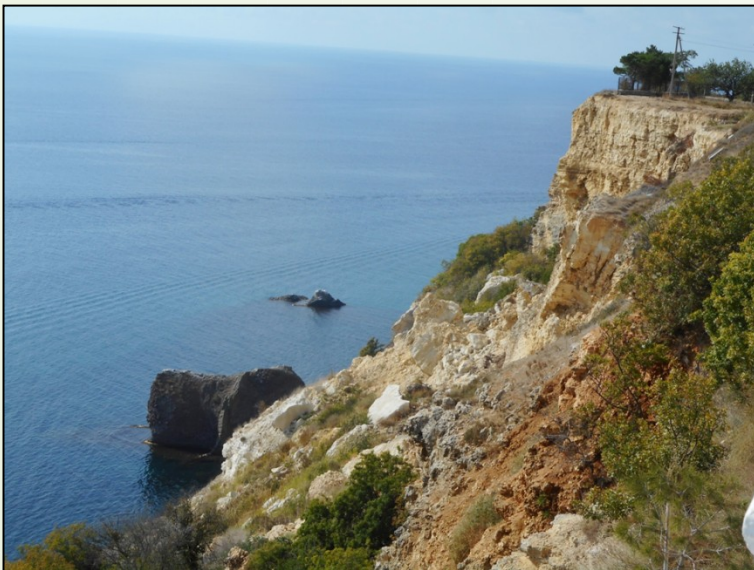
Рис. 7. Обвално-оползневой склон на террасе у базы отдыха «Каравелла», 2020 г.
