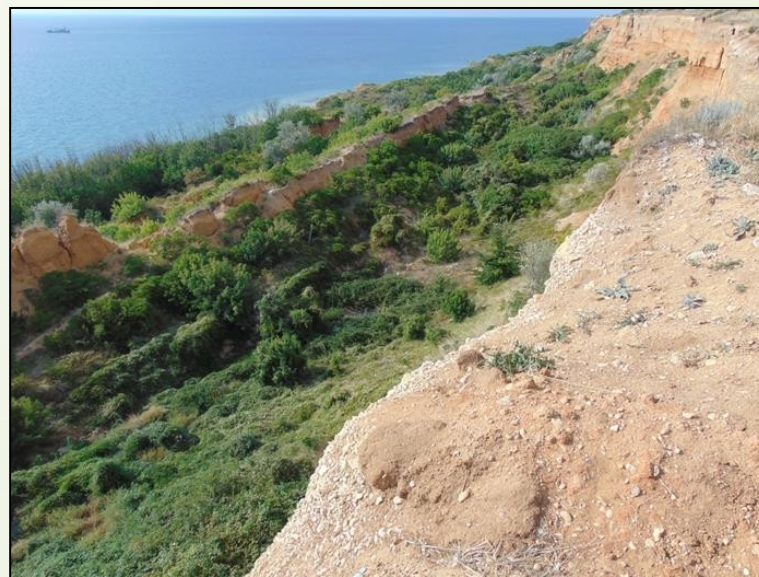
Рис. 4. Балочный оползень, 2020 г.
