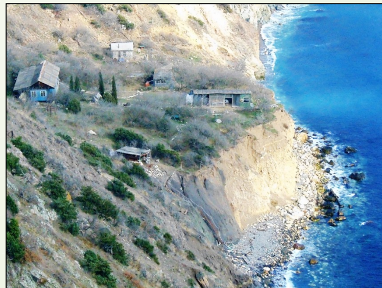
Рис. 8. Оползень северо-восточнее м. Фиолент, 2020 г.
